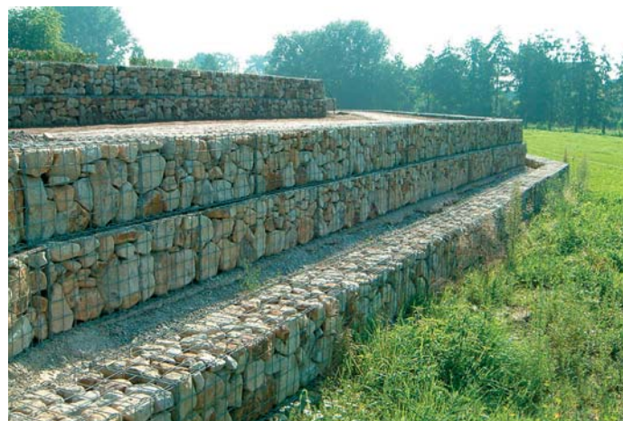
Gabionen im Bau (links).
