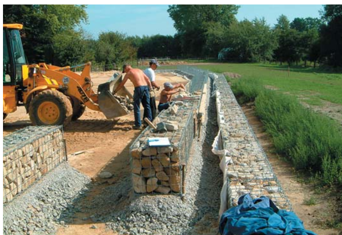
Gabionen im Bau (links).
