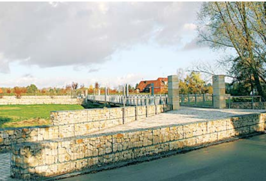
Blick über den Axtbach zum neuen Friedhof. Foto: Grachtrup
